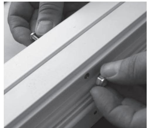
**25.** Después de encajar la barra “Mull” en su lugar, inserte tornillos 10-24 x 2 1/2” con contratuercas 10- 24 a través de los hoyos de instalación dentro de la jamba.
