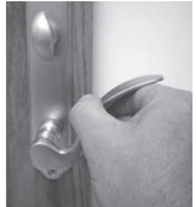
**42.** El cerrojo entra en funcionamiento al rotar la perilla giratoria en el interior o al girar la llave en la parte exterior de la puerta.
