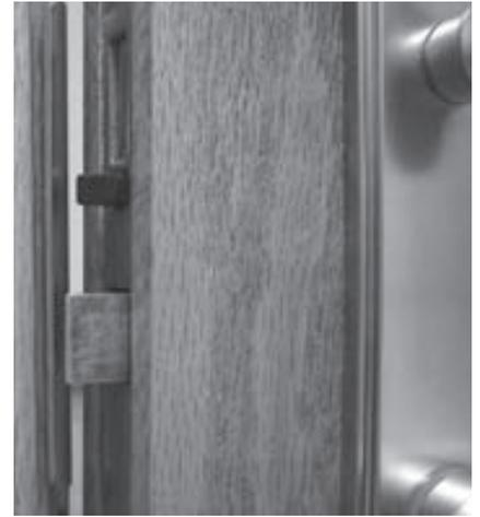
**41.** Al levantar el mango se pone en funcionamiento los pernos pasadores hacia dentro del dintel y del umbral del marco de la puerta.
